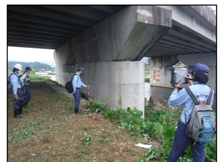
堤防点検の様子
