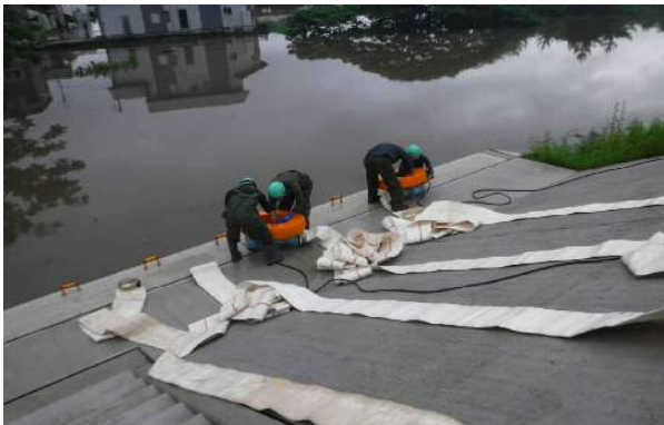
令和3年7月8日 内水排除(梅雨前線による) (倉吉市西福守地先 国府川福守排水樋門) 排水ポンプ車(19-4703)、照明車(25-4710)
