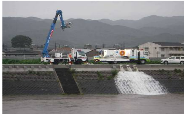
令和3年7月7日 内水排除(梅雨前線による) (倉吉市西福守地先 国府川不入岡排水樋門) 排水ポンプ車(24-4704)、照明車(R01-4704)
