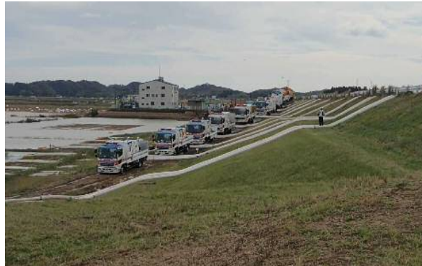
令和元年10月13日 内水排除(台風19号災害による) (宮城県石巻市地先) 排水ポンプ車3台(19-4703, 25-4705, 25-4710)
