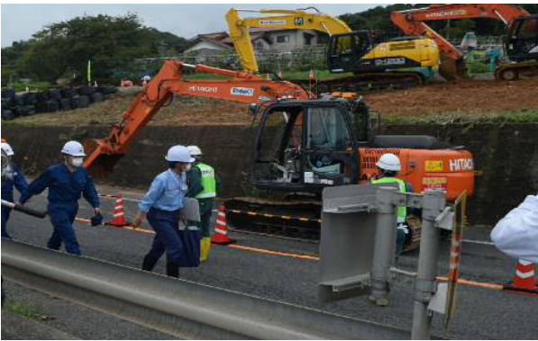
令和3年8月20日 国道9号(380k700～800付近)において、令和3年8月18日に発生した地すべり(島根県出雲市多伎町地内) 簡易遠隔操縦装置(ロボQs)(R02-1715)設置バックホウ
