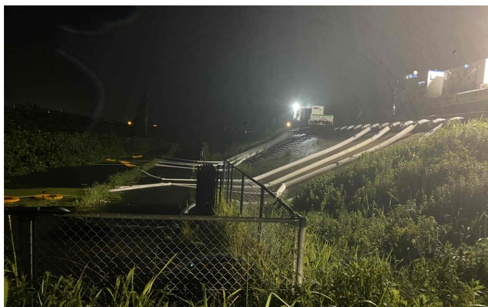
令和5年8月15日 内水排除（台風 7 号災害による） （倉吉市西福守地先 国府川不入岡排水樋門） 排水ポンプ車(R01-4701)、照明車(R01-4704)
