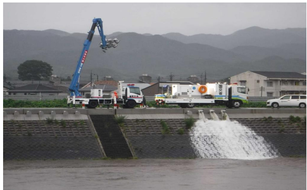
令和3年7月7日 内水排除（梅雨前線による） （倉吉市西福守地先 国府川不入岡排水樋門） 排水ポンプ車(24-4704)、照明車(R01-4704)
