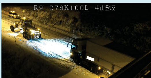
除雪グレーダーによるスタック車両牽引 (国道9号 大山町)
