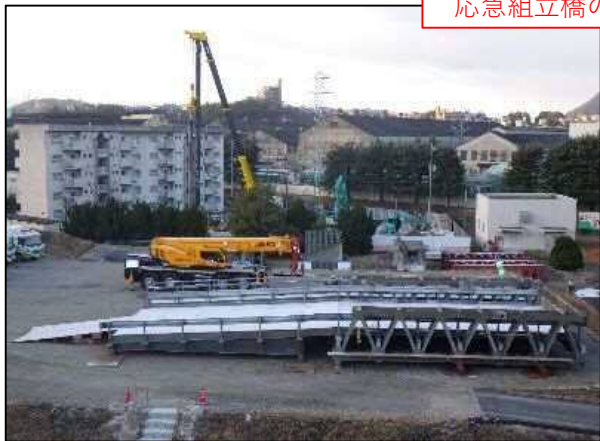
応急組立橋の仮組立状況
