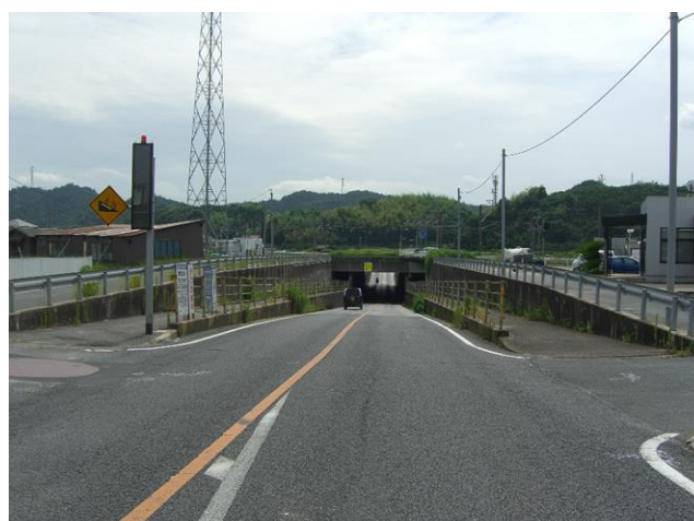
国道9号 陰田地下道
