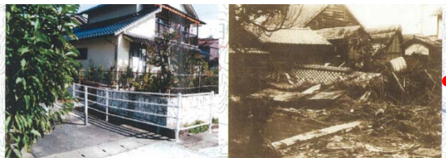
②倒壊した堺町の民家の様子
