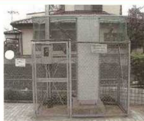
観測装置設置状況
