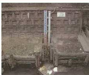
水位計設置状況
