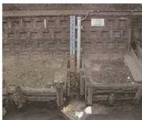
水位計設置状況
