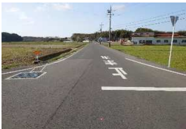
島吸道線（施工前）
