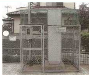
観測装置設置状況
