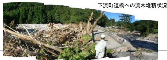
下流町道橋への流木堆積状況
