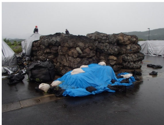
防災ステーション資材搬出状況
