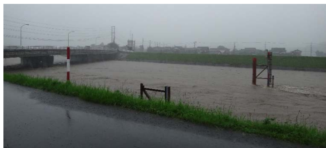
令和3年7月8日 16時10分頃 福光水位観測所 出水状況
