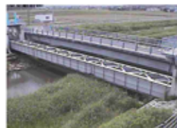
（黒河川）北条川放水路（浜川水路橋）
