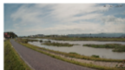
（簡易型）天神川1k600左岸 新天神橋
