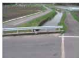
（黒河川）亀谷川
