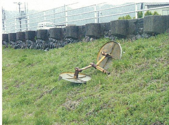
カーブミラー損傷、放置
