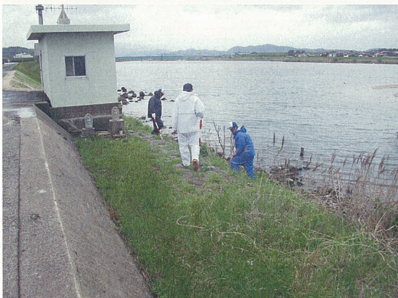
点検状況 (天神川右岸)
