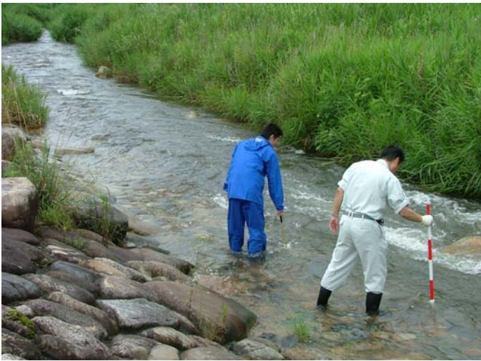
水際部の施設状態確認（中の島桜づつみ公園：三朝町）
