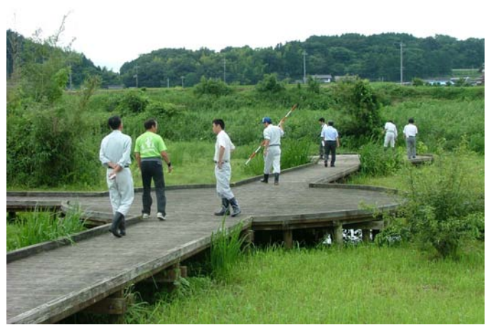
親水デッキの状態確認（上小鴨水辺の楽校：倉吉市）
