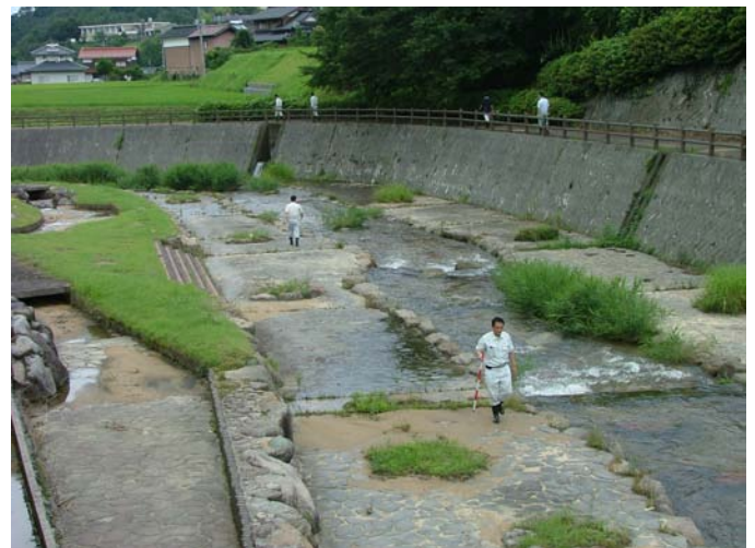
親水施設点検状況（滝川親水公園：倉吉市）
