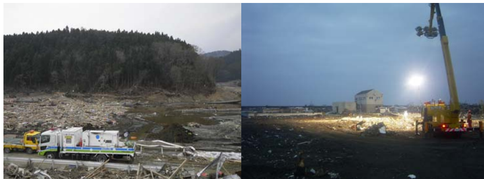
●支援機械による現地作業状況
