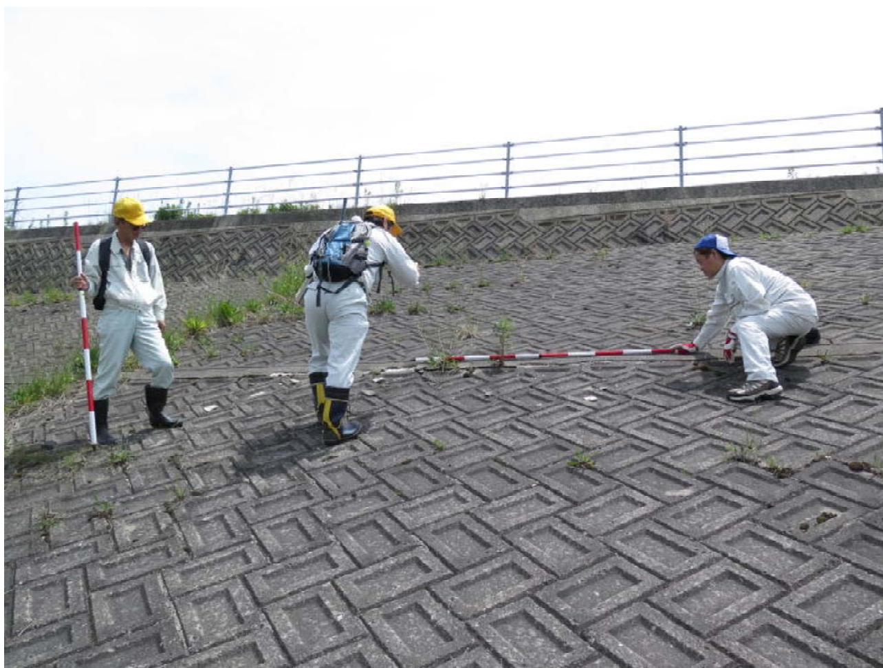
護岸目地部の開きの確認状況
