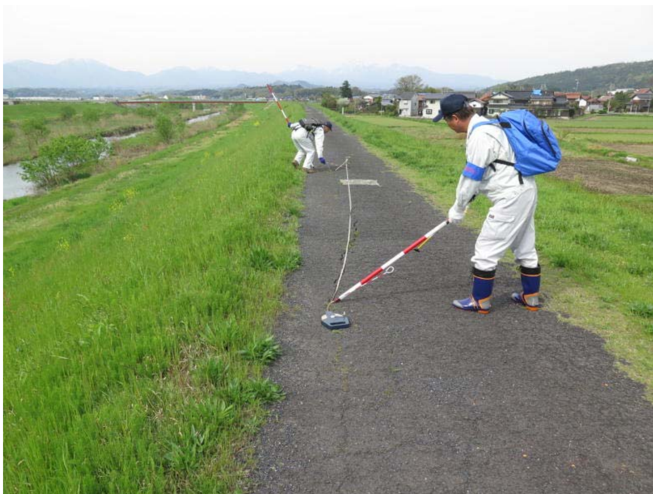
堤防舗装面のクラックの確認状況
