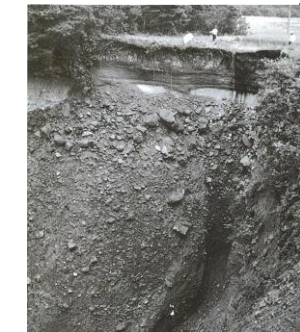
小鴨川上流、西鴨谷川崩壊地
