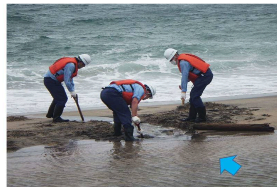
人力による維持掘削状況 (令和4年6月13日)
