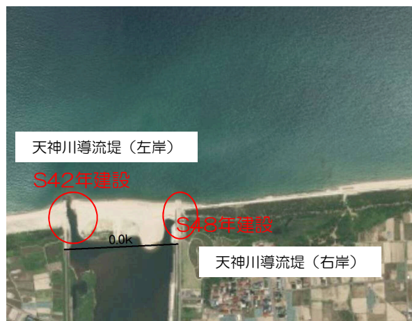
海岸整備（導流堤の建設）
