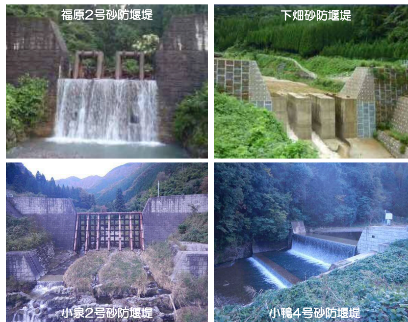
天神川流域に設置されている砂防堰堤
