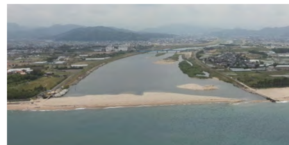
天神川河口砂州の状況 (令和4年6月3日撮影)
