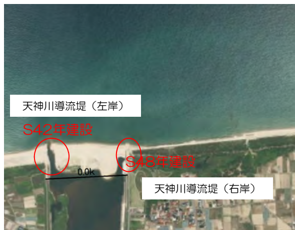
海岸整備（導流堤の建設）
