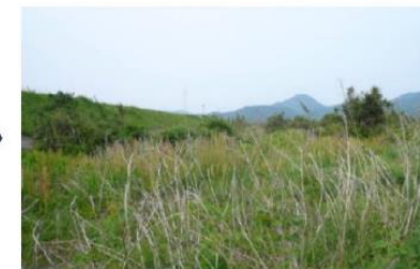
現在の小鴨川7.0km下流の状況
