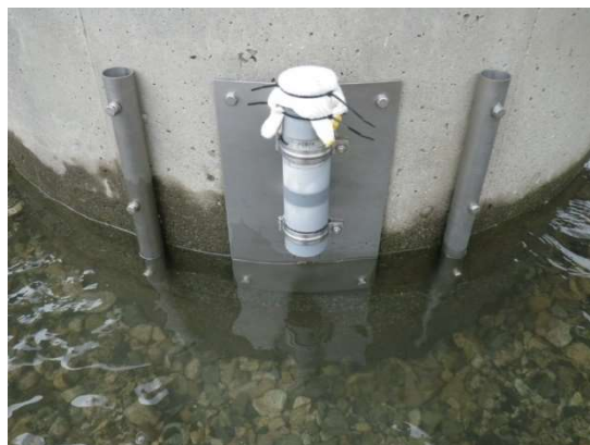
濁度計保護管の設置例
