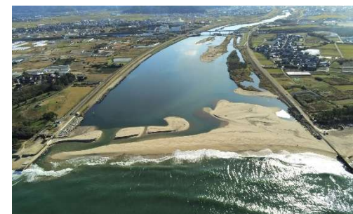
天神川河口砂州の状況 (令和5年12月4日)
