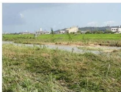
樹木伐採箇所（伐採後 2 年経過）
