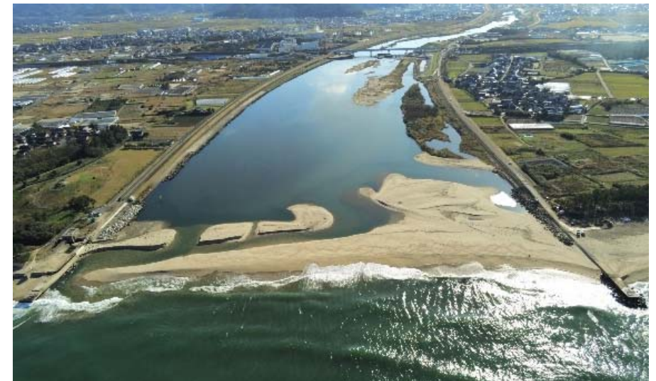
天神川河口砂州の状況 (令和5年12月4日)
