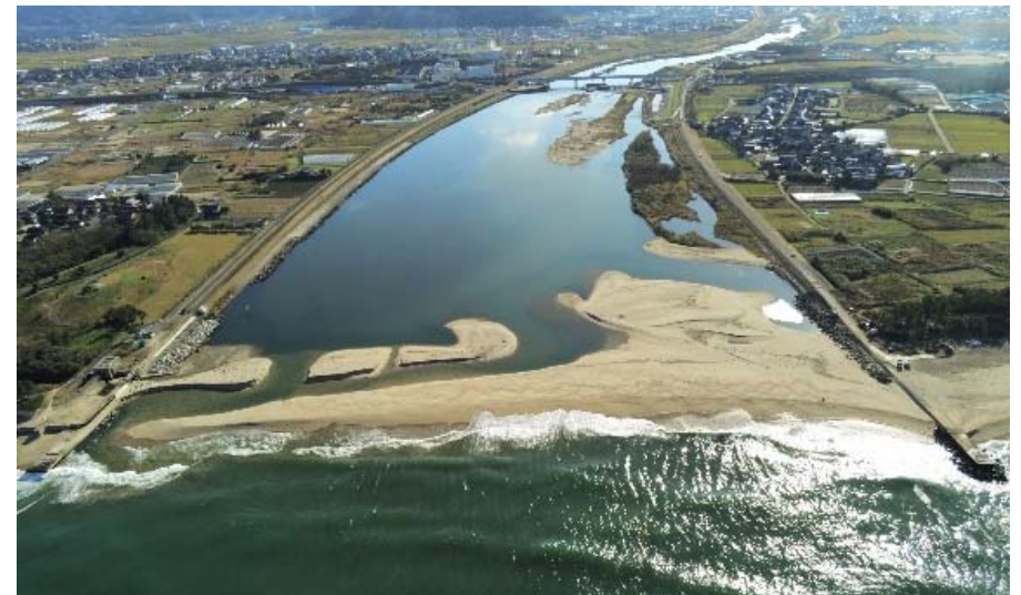
天神川河口砂州の状況 (令和5年12月4日)
