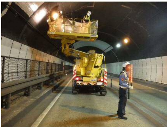
■ トンネル点検
