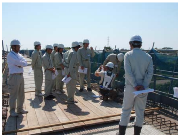
工事担当者からプレキャスト橋梁工事の作業内容を聞く見学者
