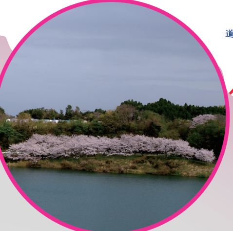
⑮ 西高尾ダム
