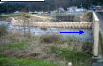
工事中の様子
