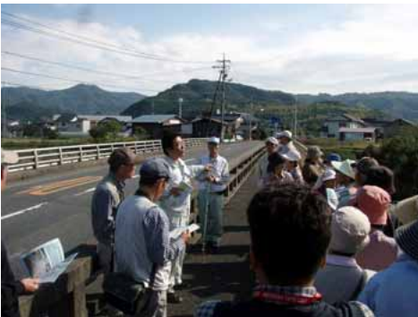
◀河戸橋工事説明
