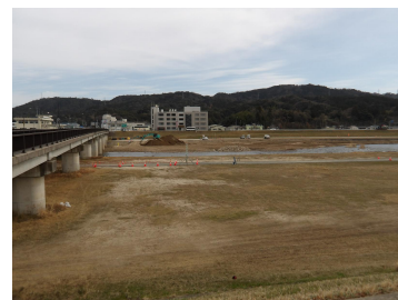
(工事実施状況)
