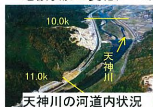
天神川の河道内状況
