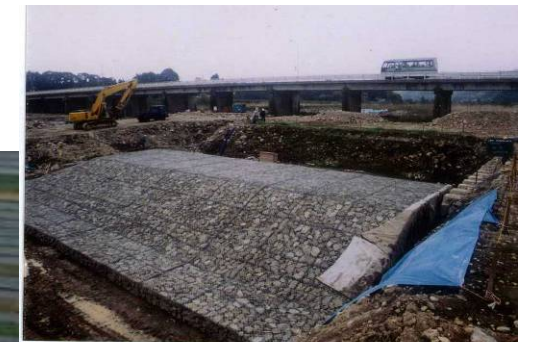
河岸侵食防止工施工状況
