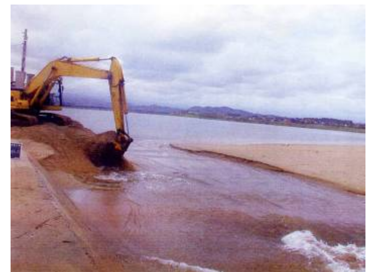
波浪等や流量減少の影響により河口閉塞が発生した場合には、砂州の小規模な掘削を行い対応。(平成16年8月20日の作業)
