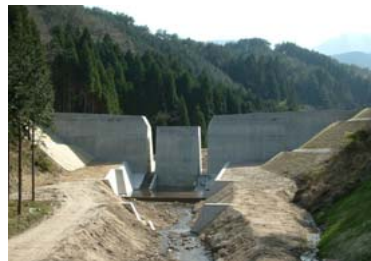
スリット型砂防堰堤 (堀3号堰堤)
