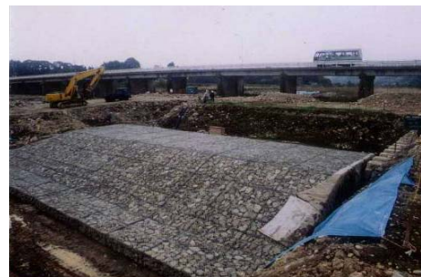
河岸侵食防止工の施工例(小鴨川)
