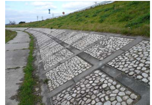
高水護岸の施工例
