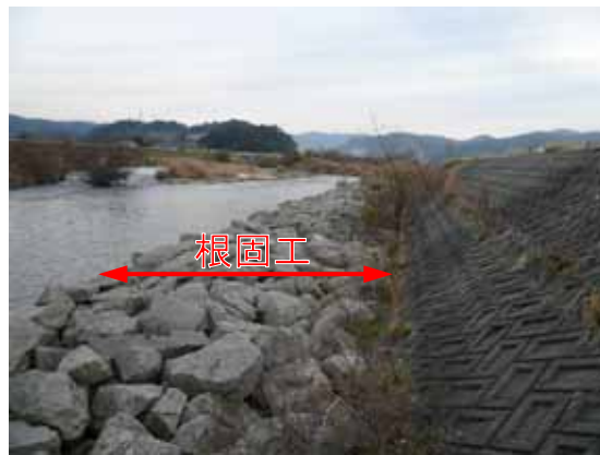
根固工の施工例
