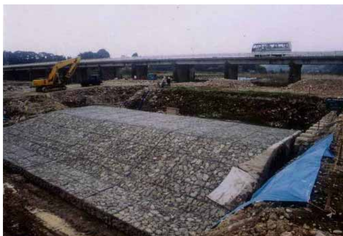
小鴨川における河岸侵食防止工の設置事例
