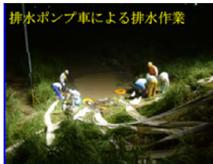
排水ポンプ車による排水作業 排水ポンプ車の活動状況 (平成 17 年台風 14 号)
