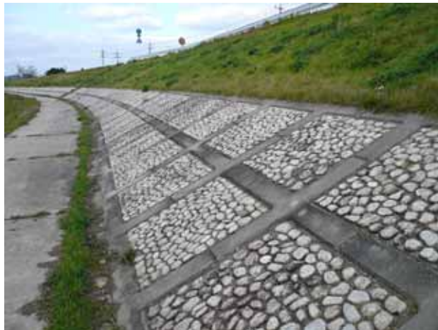
高水護岸の施工例
