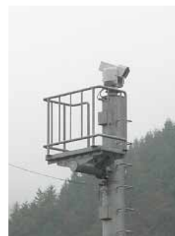
河川監視カメラ
