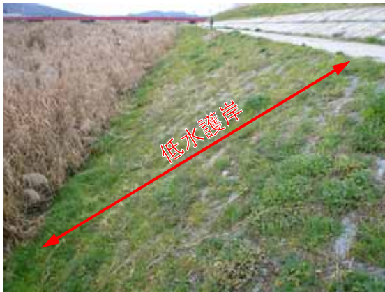
低水護岸の施工例
