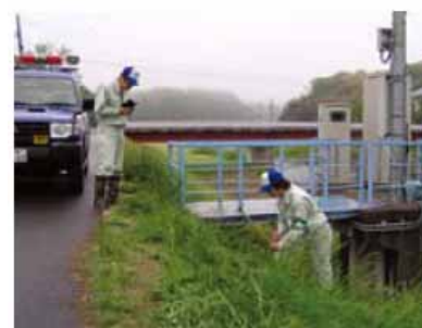
排水門の点検状況
