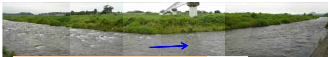
現在の水管橋（小鴨川 9.2km）付近の状況
