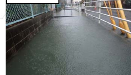
付近の浸水状況
