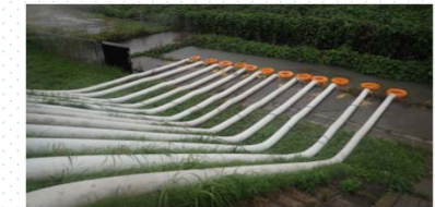
排水状況（不入岡排水樋門）
