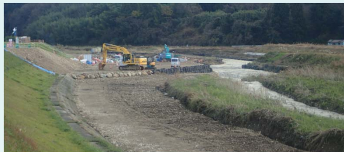
オヶ崎堰本体工の施工状況
