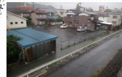
浸水状況（玉川上流排水樋門）
