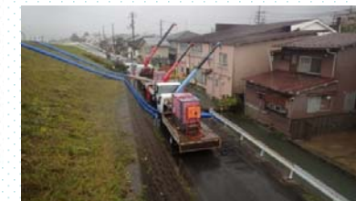
排水状況（玉川上流排水樋門）
