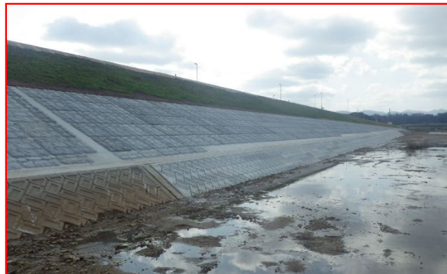
18 河岸侵食防止対策実施状況 (秋喜地区)
