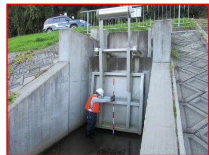
排水門の点検状況
