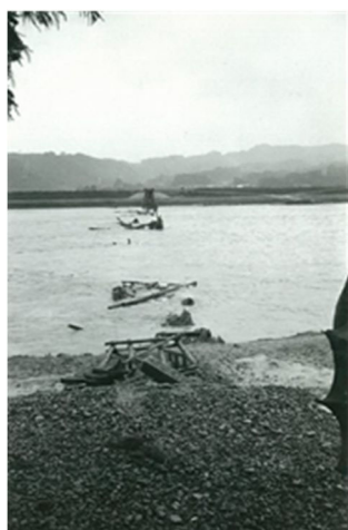
昭和34年(1959年)伊勢湾台風洪水 大塚橋の流失状況
