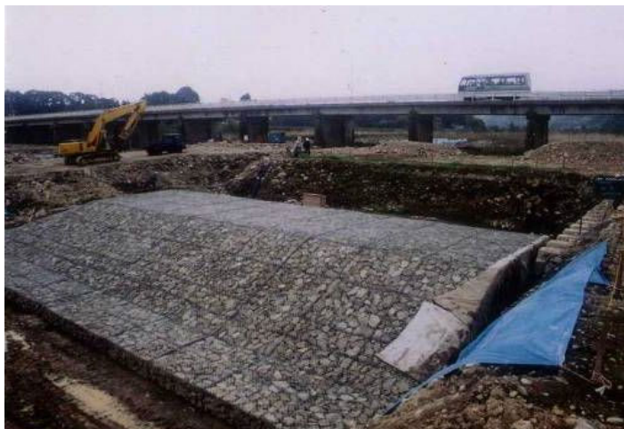
18 小鴨川における河岸侵食防止工の設置事例
