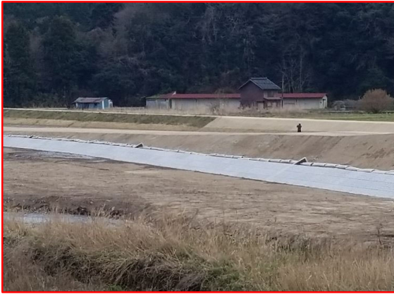
低水護岸工の施工例
