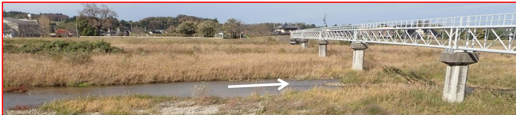
現在の水管橋(小鴨川 9.2km)付近の状況 (河道内に植生が繁茂)
