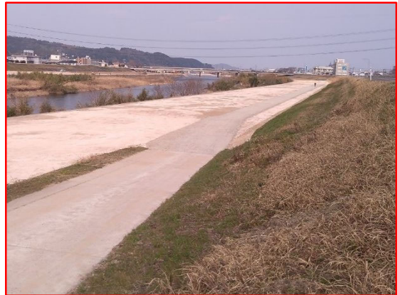
河川敷保護工の施工例
