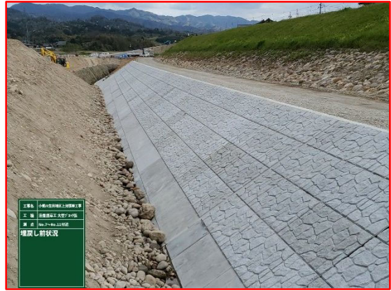
根継工の施工例
