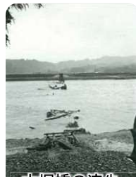
大塚橋の流失 (S34 年伊勢湾台風洪水)
