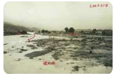
倉吉市関金地区の堤防決壊 (S34 年伊勢湾台風洪水)
