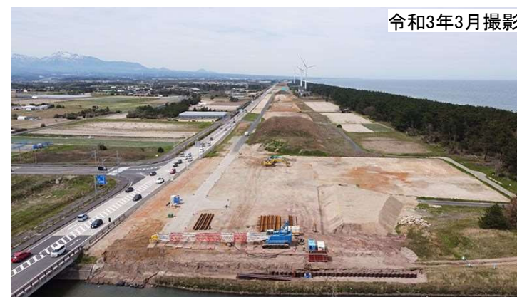
北条道路の建設中の様子
