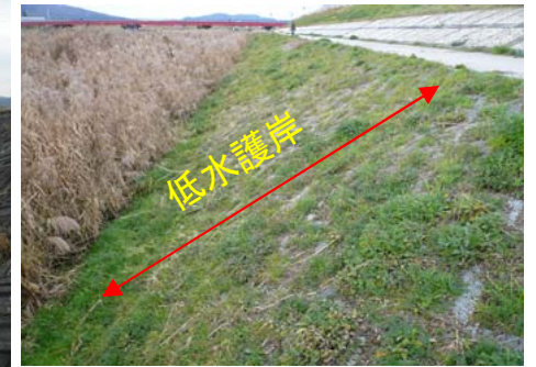
「低水護岸」の施工例
