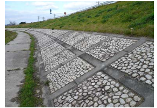
高水護岸の施工例
