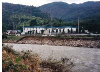
平成10年10月洪水による三朝町内における護岸の被災状況
