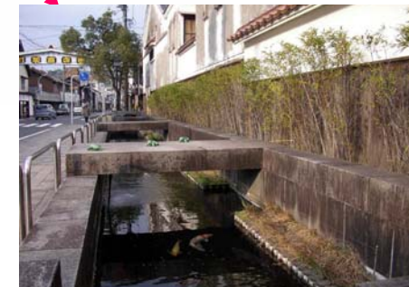
倉吉市内の白壁土蔵群と支川玉川
