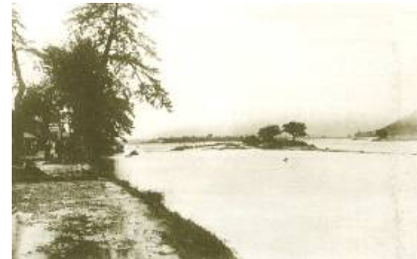
③堤防が決壊した旧倉吉駅裏
