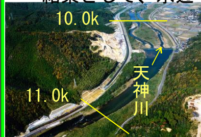
天神川の河道内状況
