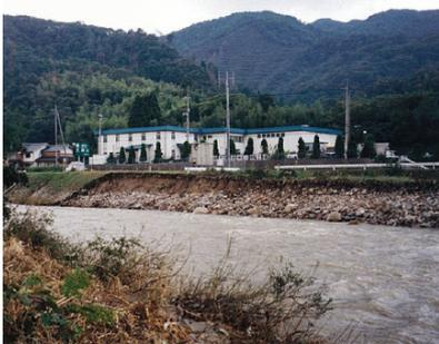
平成 10 年 10 月洪水による三朝町牧地区における護岸の被災状況
