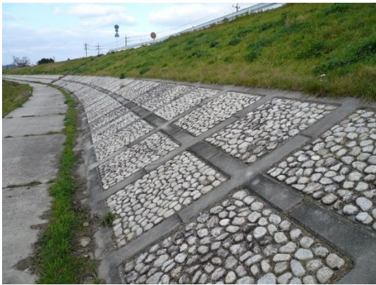
高水護岸工の施工例
