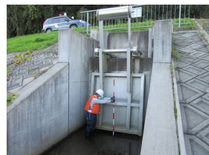
排水門の点検状況
