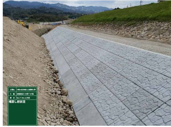
根継工の施工例
