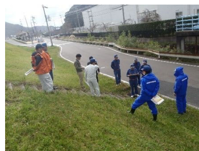
重要水防箇所の現地確認
