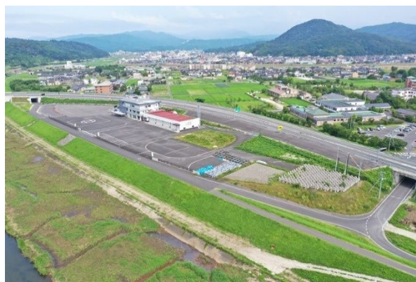
天神川河川防災ステーション (平成27年(2015年)3月完成)
