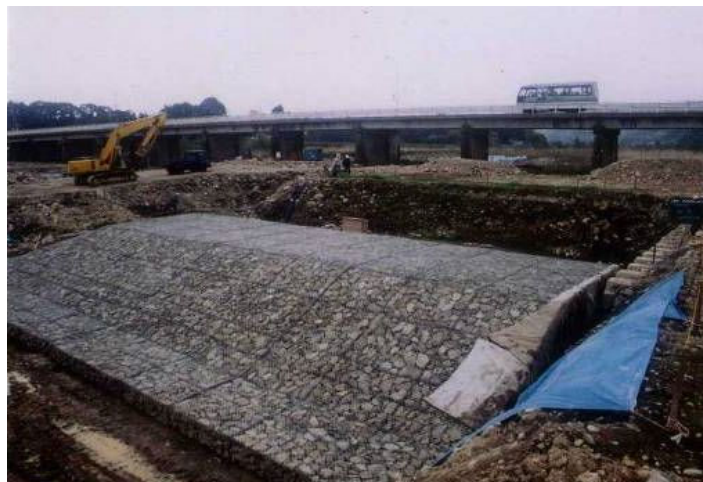
小鴨川における河岸侵食防止工の設置事例
