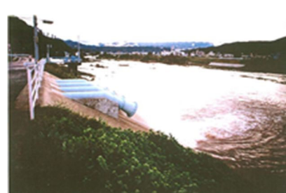
平成10年(1998年)10月台風洪水 倉吉市和田地区の排水機場稼働状況
