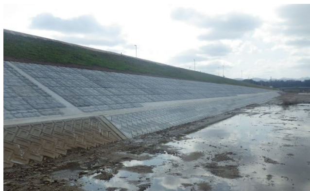
河岸侵食防止対策実施状況 (秋喜地区)
