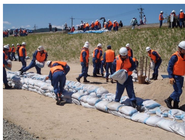
倉吉市内の天神川河川敷で行われた水防演習の様子
