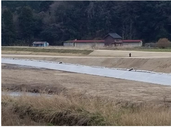
低水護岸工の施工例
