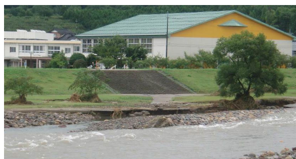
図 5.1.3 平成23年(2011年)9月洪水による倉吉市下大江地区における護岸の被災状況
