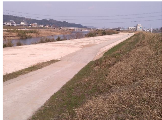
河川敷保護工の施工例
