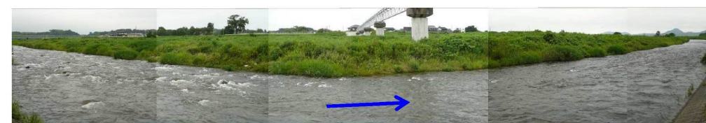
現在の水管橋（小鴨川 9.2km）付近の状況（河道内に植生が繁茂）
