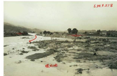
昭和 34 年(1959 年)伊勢湾台風洪水 倉吉市関金地区の堤防決壊状況
