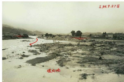
昭和 34 年伊勢湾台風洪水 倉吉市関金地区の堤防決壊状況
