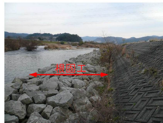
根固工の施工例
