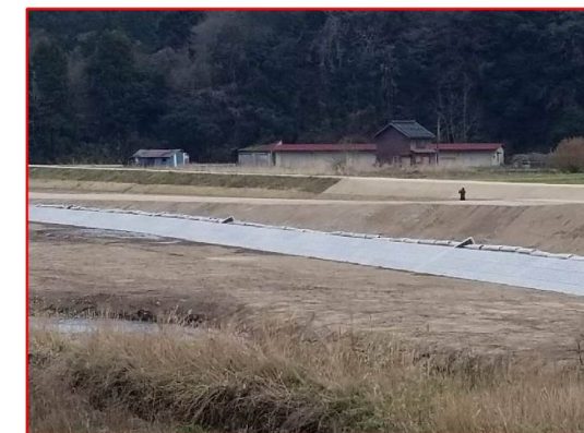
低水護岸工の施工例
