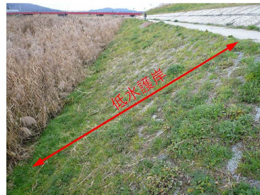
低水護岸の施工例
