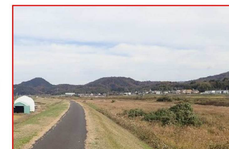
現在の小鴨川 7.0km 下流の状況
