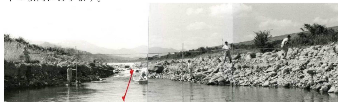
倉吉市関金地区での河床洗掘状況（平成 2 年、小鴨川）
