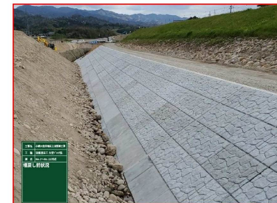
根固工の施工例
