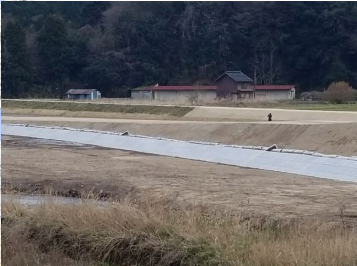
低水護岸工の施工例
