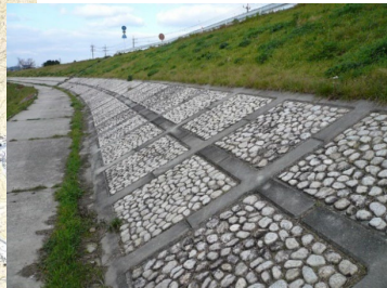
高水護岸工の施工例
