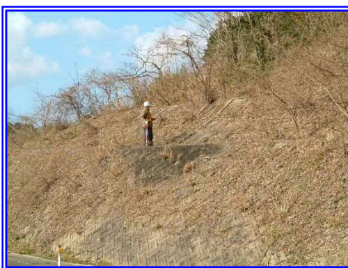
定期巡回（法面確認）
