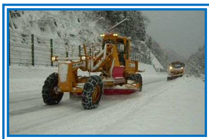
除雪（新設除雪）
