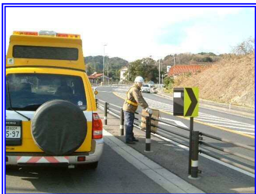
通常巡回（落下物処理）
