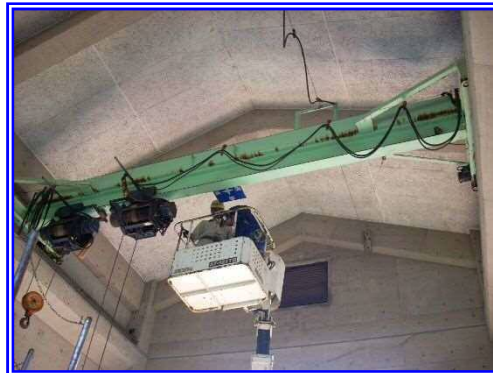
除雪基地設備点検
