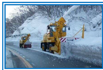
除雪（拡幅除雪）
