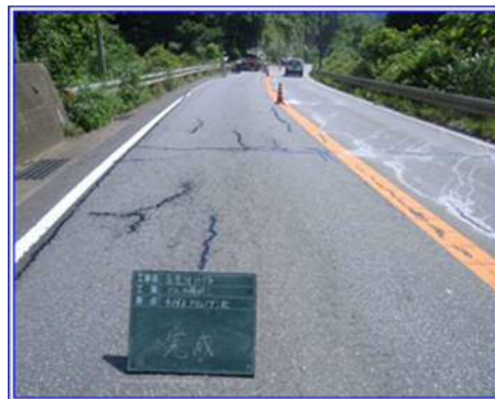
シール材の注入
