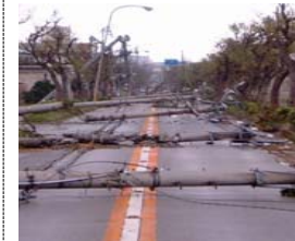
<電柱の倒壊による道路閉塞の事例>
