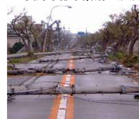
＜電柱の倒壊による道路閉塞の事例＞
