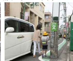
＜歩行の支障となる電柱の事例＞
