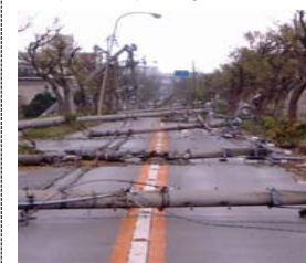
＜電柱の倒壊による道路閉塞の事例＞
